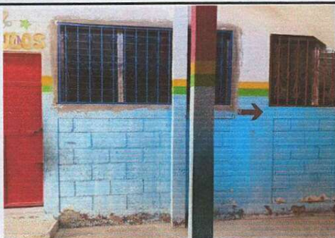
Foto 1: PINTURA sustitución de pintura existente en malas condiciones del frente de la escuela, área de patio, escenario y exterior del aula uno y dos, con pintura de color: azul, blanco, amarillo y verde.
