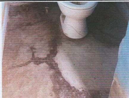
Foto 4: PISO Reemplazo de suelos, por concreto con espesor de 8 centímetros en el área de baños
