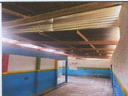
Foto 5: CUBIERTA DE LAMINA Sustitución de lámina actual (acanalada) en mal estado, por lámina troquelada calibre 26 legítima, en área de patio
