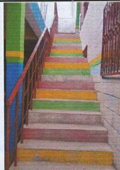
Foto 2: MANTENIMIENTO A BARANDAS Reemplazo de pintura por pintura anticorrosiva en baranda, hacia el segundo nivel de aula 1 y 2
